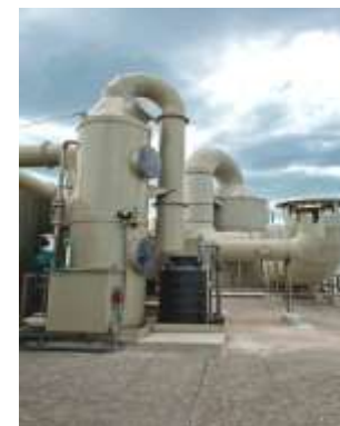
一次銅 L 線廢氣塔&蝕薄銅加棕化線廢氣塔
